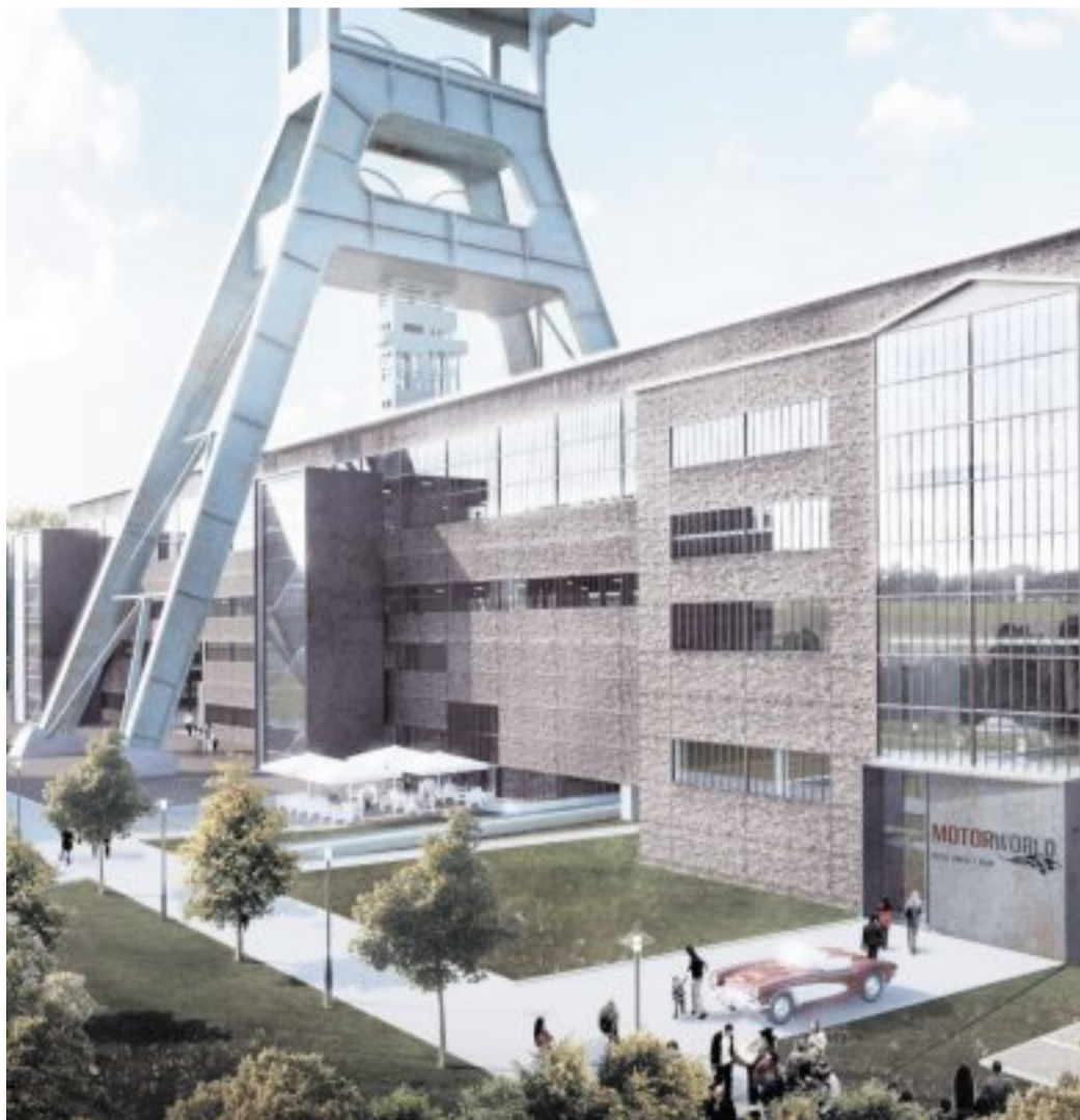
So soll die Rasenhängebank, das Herzstück der „Motorworld“, im Jahr 2018 aussehen: Behutsam und im Einklang mit dem Denkmalschutz werden große Glasflächen in die sanierten Ziegelfassaden eingefügt und Treppenhäuser angebaut (hinten links im Bild). Das Umfeld soll begrünt werden.
