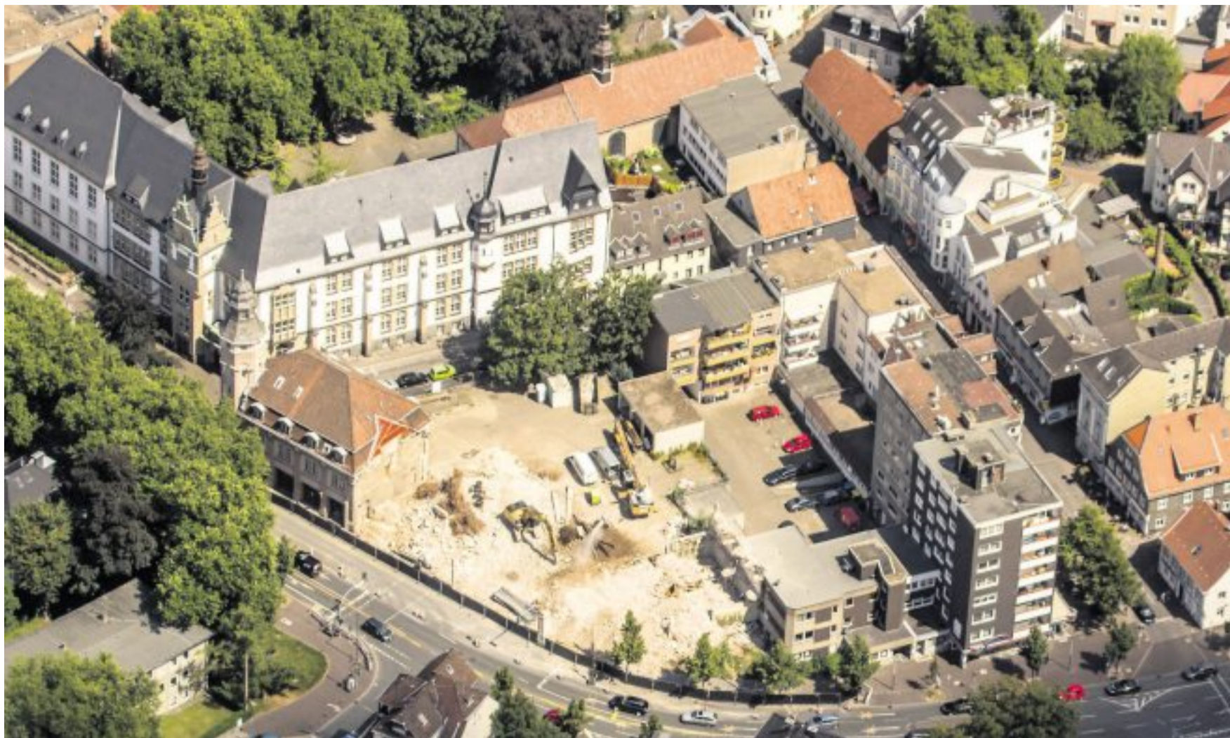
Im Zeitplan liegt der Teilabriss der Feuerwache. Aktuell steht nur noch der denkmalgeschützte Teil samt Schlauchturm (l.), der restauriert werden soll. Bis zum Baustart für das neue Parkhaus sollen auf dem Gelände rund 70 Abstellplätze zur Verfügung gestellt werden. —LUFTBILD: GUTZEST
